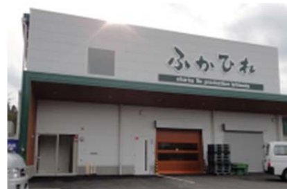
高台に完成した新工場
